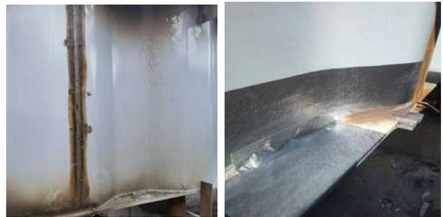
工地焊接气刨清根烧坏周围漆面 采用铝箔壁纸进行漆面保护
