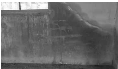
图1 外墙渗漏
