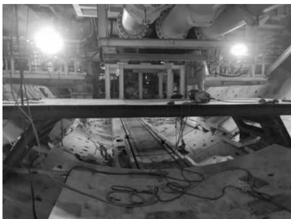
图1 安装压重平台
