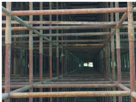
图 1 现场支架搭设图片
