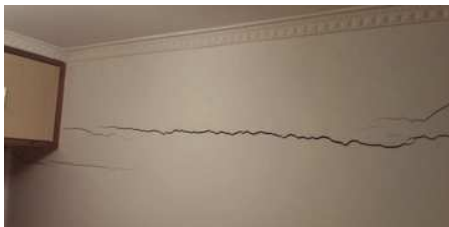
图1 温度裂缝
