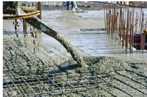
图1 房屋混凝土浇筑技术
