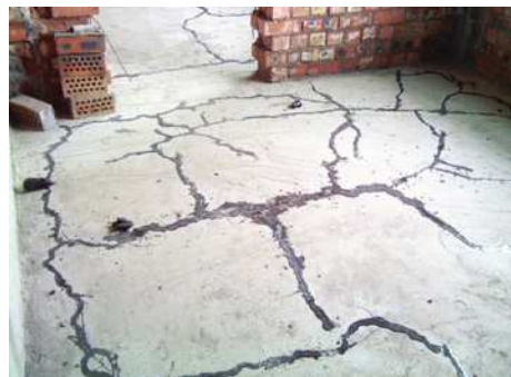
图1 混凝土裂缝
