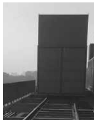
设备吊装就位
