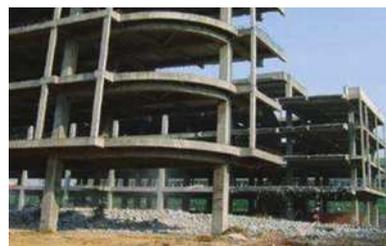
图1 钢筋混凝土框架结构
