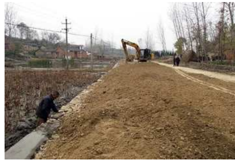
图1 农村公路建设现场
