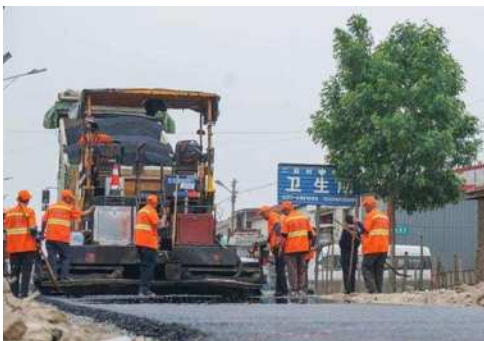
图2 2021年某农村公路建设有序推进
