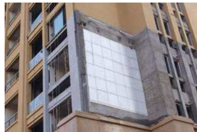
图2 真空绝热板在建筑外墙保温施工中的应用
