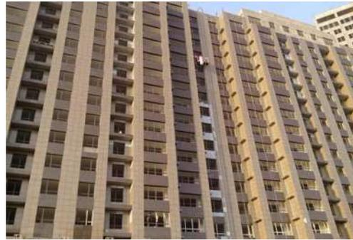
图1 建筑墙体节能保温装饰一体板
