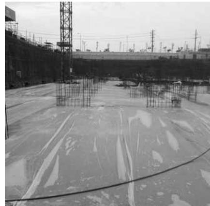
图1 混凝土的养护
