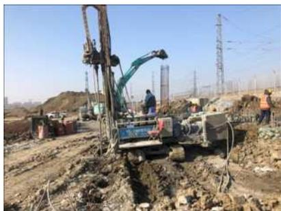
图 高压旋喷柱
