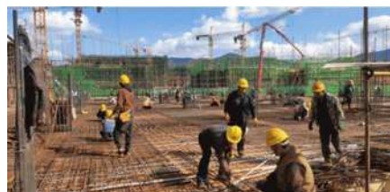
图7 工人现场施工图
