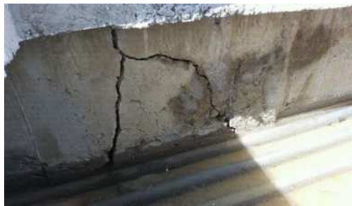
图1 墙体开裂图
