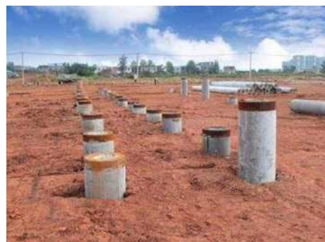
图4 混凝土预制桩图
