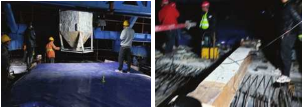
图 3.3-1 合龙段配重及临时锁定
