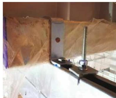
图4 主次钢梁固定示意图
