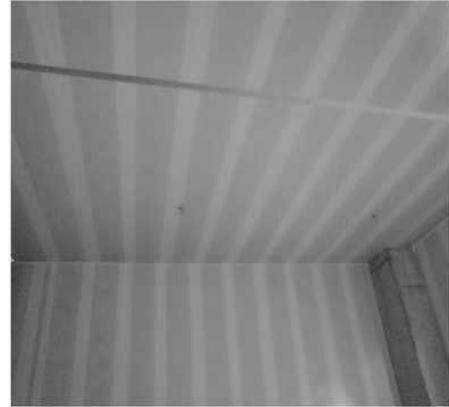
图3 顶板安装
