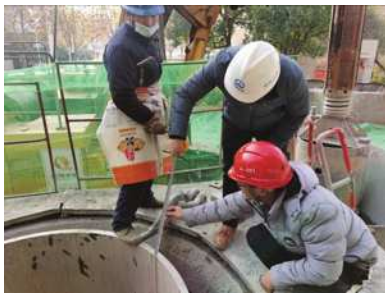
图2 桩基终孔验收
