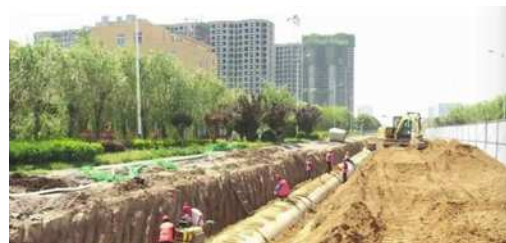
图1 给排水管道现场施工环境
