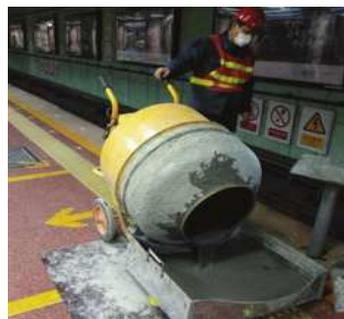
图4 利用浇筑槽浇筑示意图
