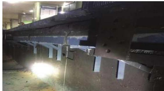
图6 站台槽形板加固完成照
