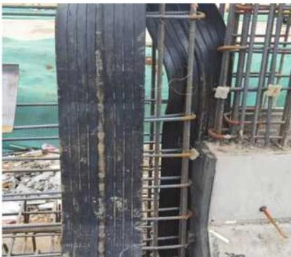
原因分析：操作工人质量意识差，止水带定位不准确，安装随意性太强；止水带固定的不够牢固，施工过
