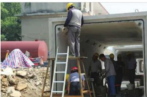
原因分析：对于预应力拼装式管廊主体，常会遇到张拉数值与设计偏差较大，以及压浆工艺不饱满的质量通病。预应力施工具有一定的危险性，同时也是施工中最重要的一步，预应力偏差过大本人认为主要原因有：张拉千斤顶、油泵等设备长时间未校准或计量不准确；对于使用手动式张拉设备，油表指针度数不准确，一般油表最多精确至1MPa以下，度数只能估读，而持荷时候指针往往来回摆动。
