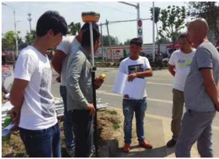
测量交桩是由建设单位组织，监理单位参加，设计单位向施工单位现场进行交桩，目的在于将设计图纸中的高程控制点、平面控制点在现场标出，并做好保护。尤其是标段起点和终点的桩位，图纸设计给出的往往不是国家标准的桩位，很可能由于时间太久，发生改动或偏移。交桩的资料要越全越好，以便于后期补桩，尤其对于补充性和变更的文件更加重要，务必要交接齐全。
