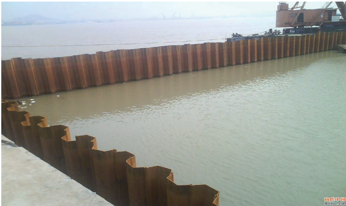
图1 钢板围堰施工技术图
