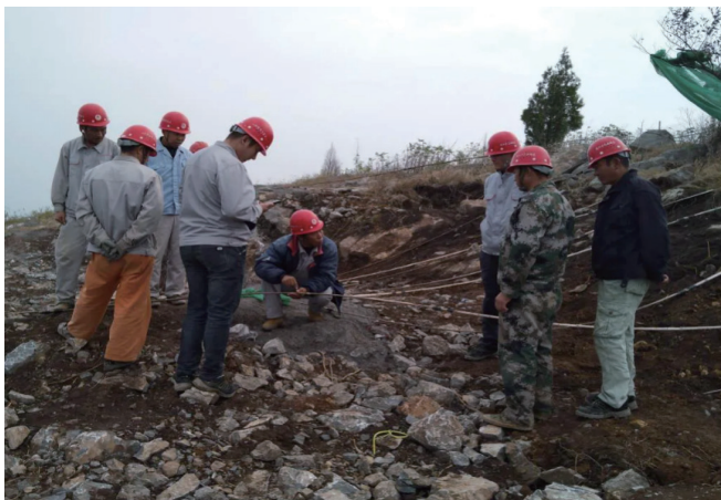
图1 边坡爆破施工
