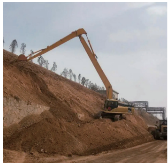
图2 边坡开挖施工
