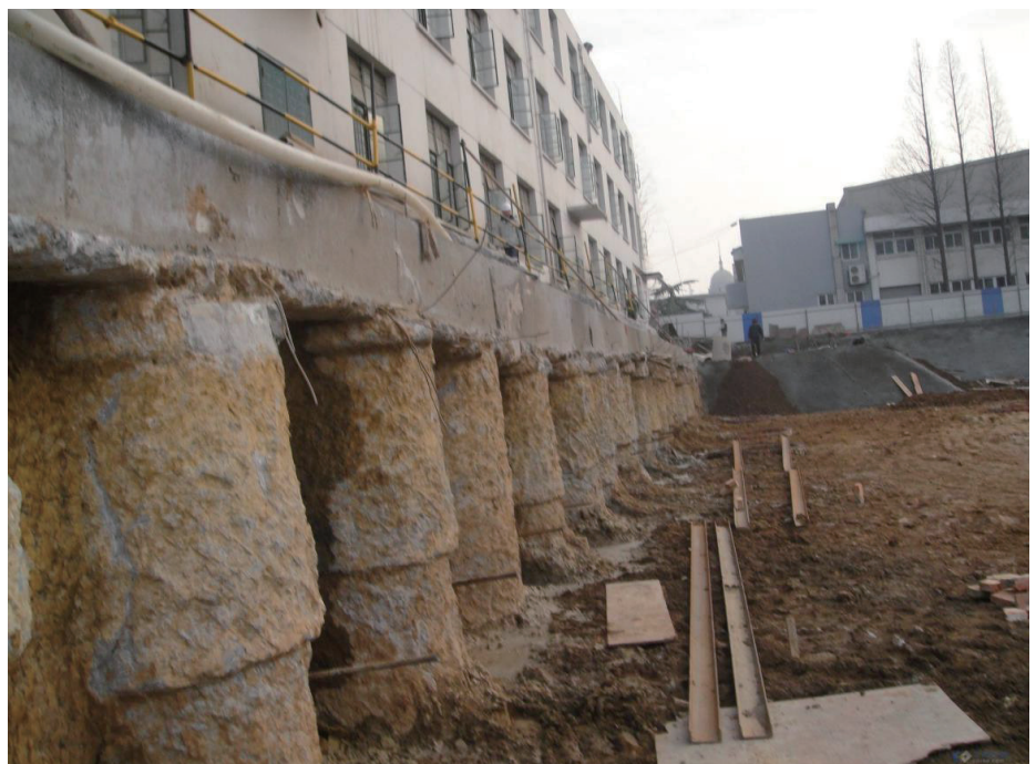
图1：护坡桩施工图片
