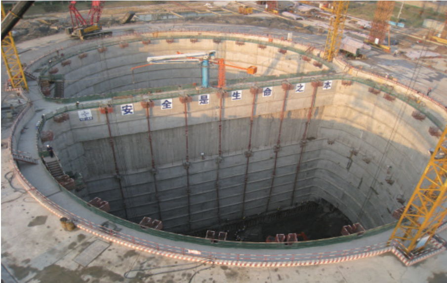
图2: 地下连续墙施工图片
