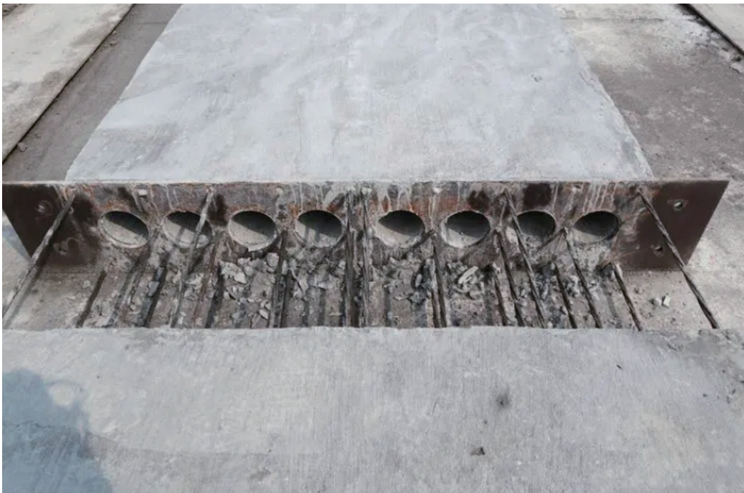
图1 预应力混凝土空心板结构
