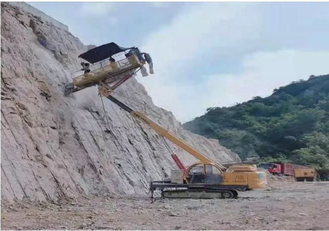
图2 XC-30高举护坡锚固钻机现场造孔照片
