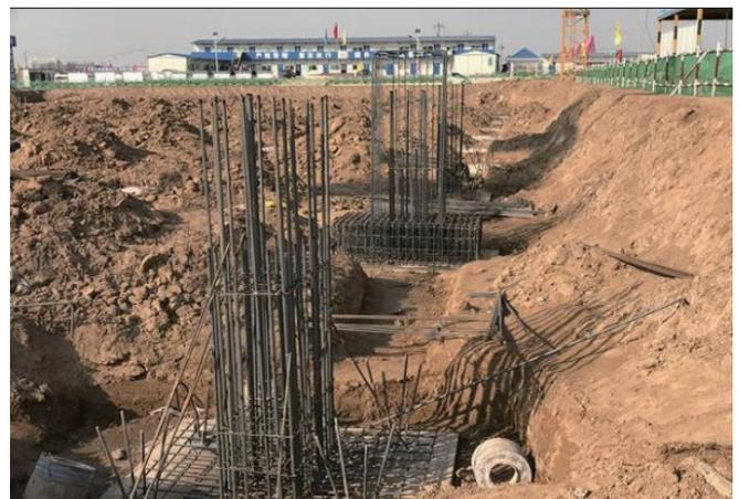
图1 桩基础施工
