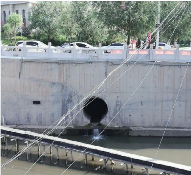
图2 路桥工程路面排水管道形式
