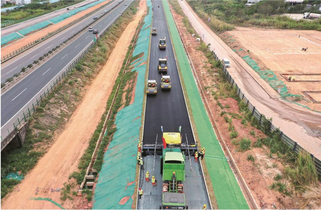
(图2 为路基施工) (此图为路面施工图)
