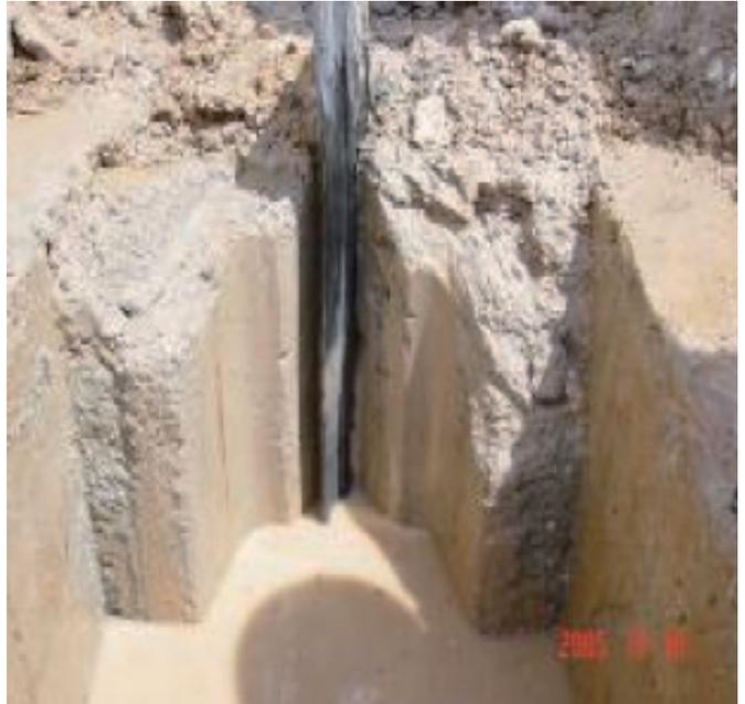
图6 锁口桩拔出后
