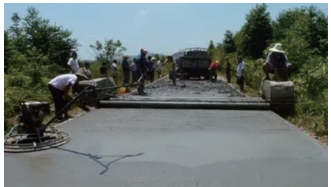
图1 水泥混凝土路面接缝
