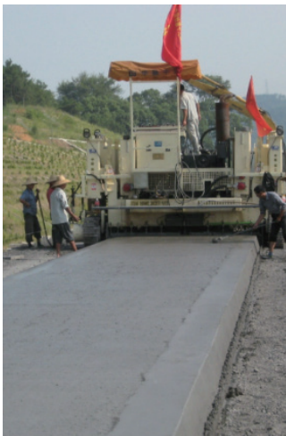
图2 滑模摊铺机进行水泥混凝土路面摊铺
