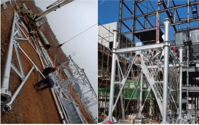
图6.3 现场钢结构桁架模块拼装图
