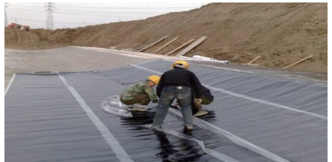
图一 屋面保温施工
