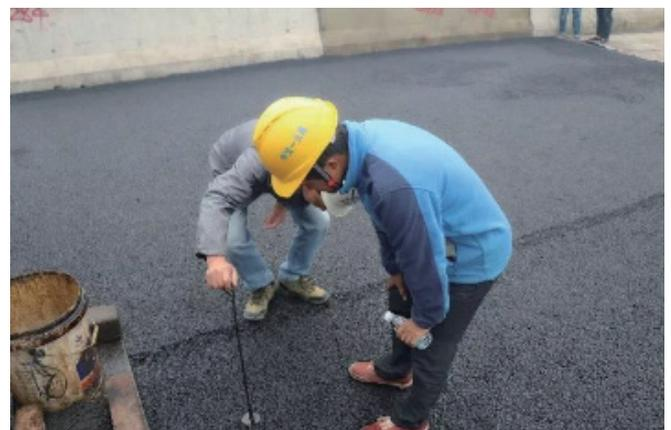
图2 沥青混凝土试验检测
