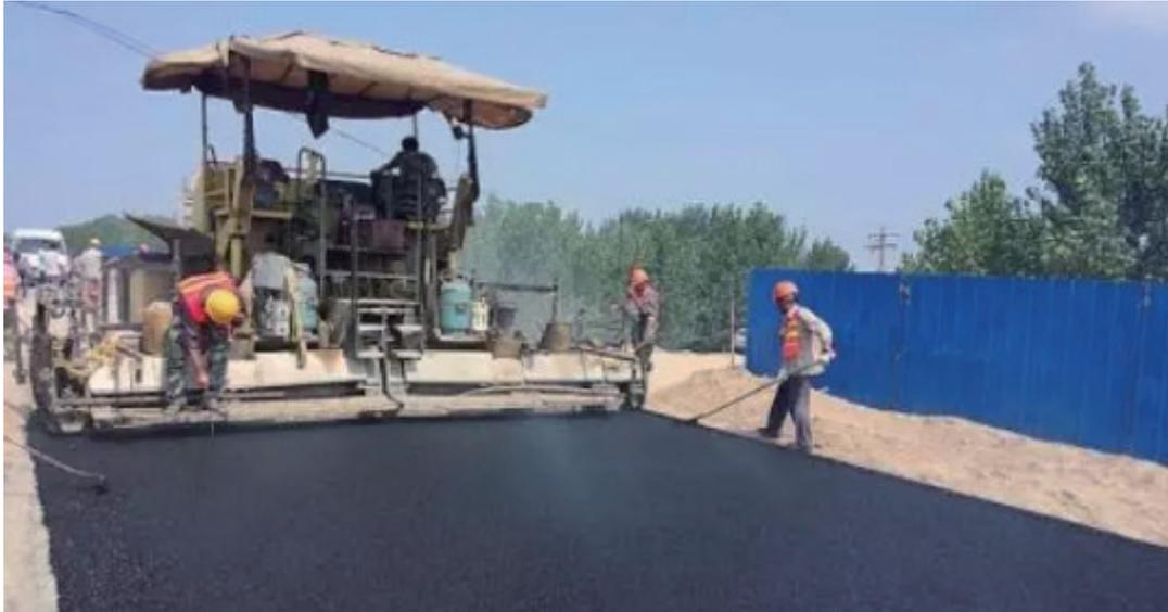
图1 沥青混凝土施工
