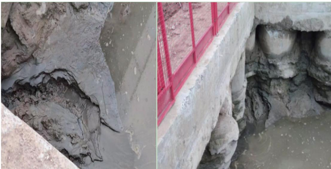
图1 高压旋喷桩止水帷幕基坑渗漏情况
