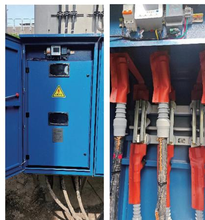
图5 隔离柜正面图（未安装传感器）
