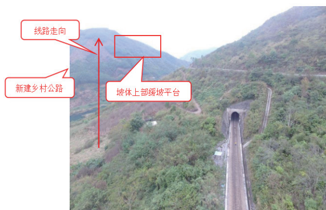
图3 尾祖一号隧道进口全貌
