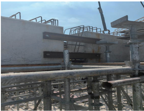
图3主次梁钢筋锚固节点成型质量图
