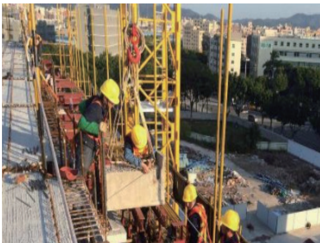
图9 悬挑梁安装固定
