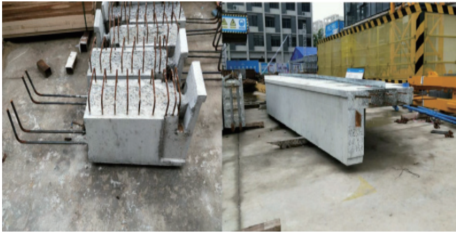
图3 悬臂短梁、预制阳台板实物图
