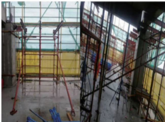
图8 支撑架搭设图
