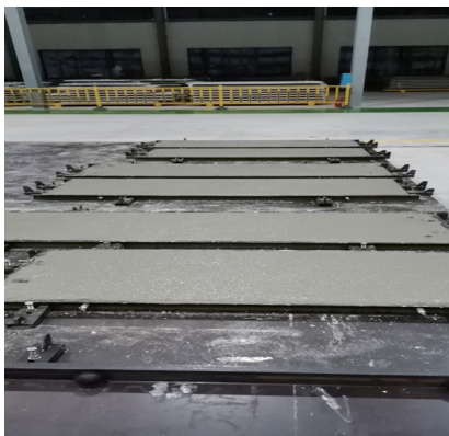
图1 承台地梁模板工厂制作流程
