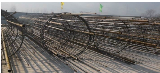
桩、柱钢筋笼预制成型
