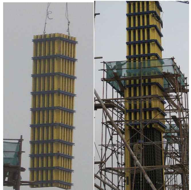
大模板吊装加固成型
