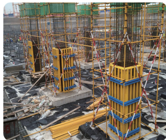
木梁大模板体系应用
