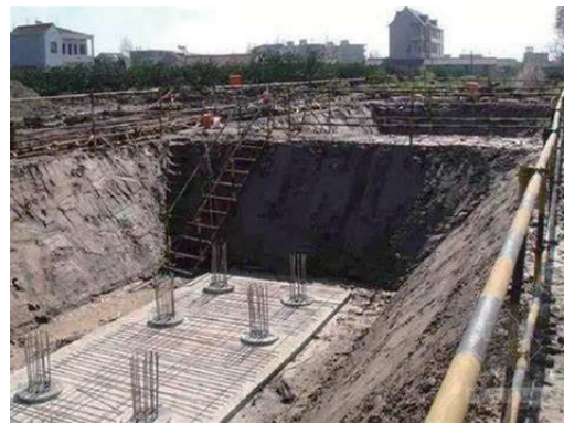
图1 地下管廊明挖基坑施工
