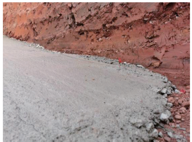
图1 基础垫层未达到标高厚度
