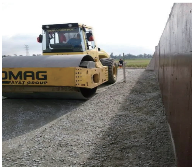
图1 路基填筑施工图
