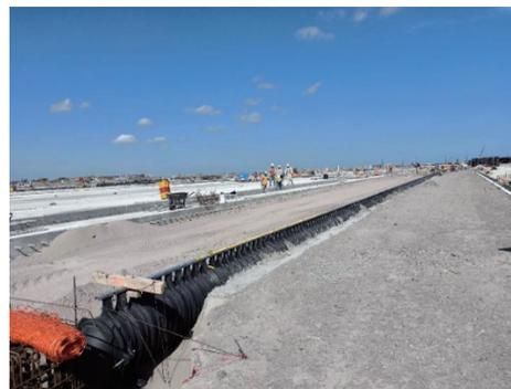
HDPE排水管第二层浇筑混凝土及完成后效果图
