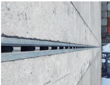
HDPE排水暗沟顶部面层浇筑与HDPE排水暗沟成品图
