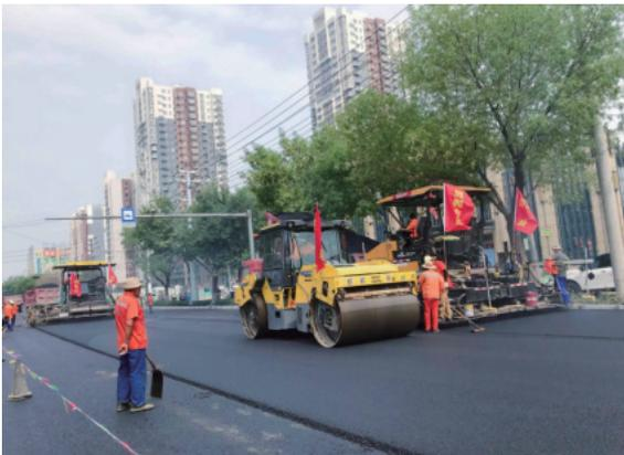
图1 某路段机动车道面层沥青摊铺
