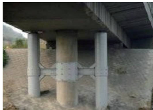
图4.4 扩大基础+增设墩柱现场照片
