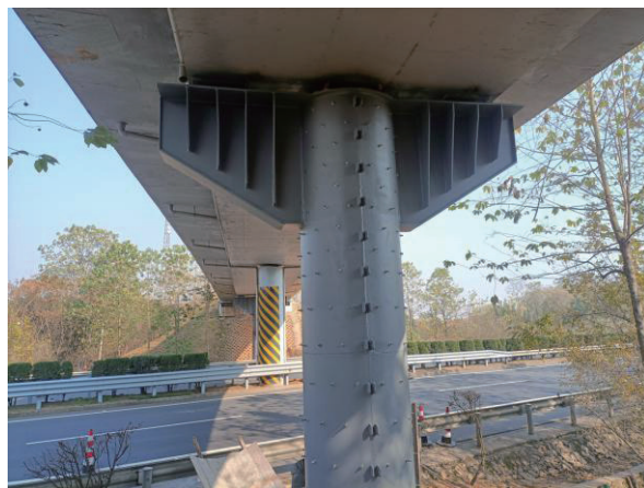
图4.2 加钢盖梁+钢套筒现场照片
