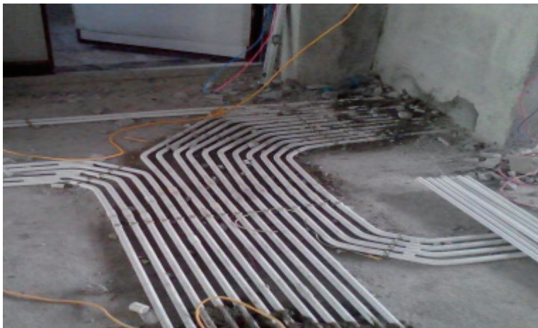
图1 建筑水电安装焊接
